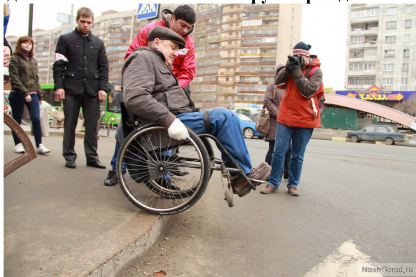
Рисунок 4.18.3 – Пешеходный переход, не обеспечивающий условия движения маломобильных групп граждан.
